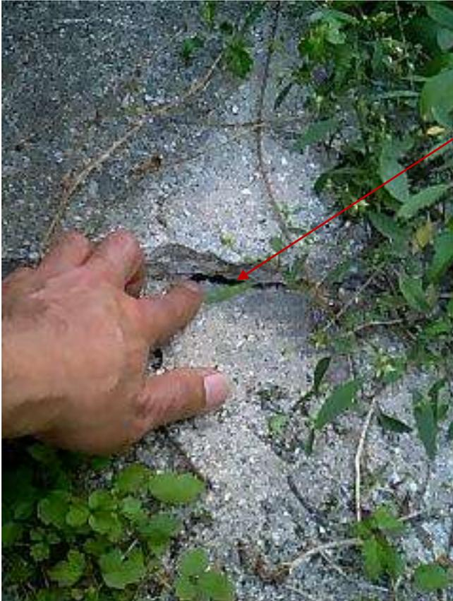
駐車場は空洞化があり、亀裂と陥没を認める
